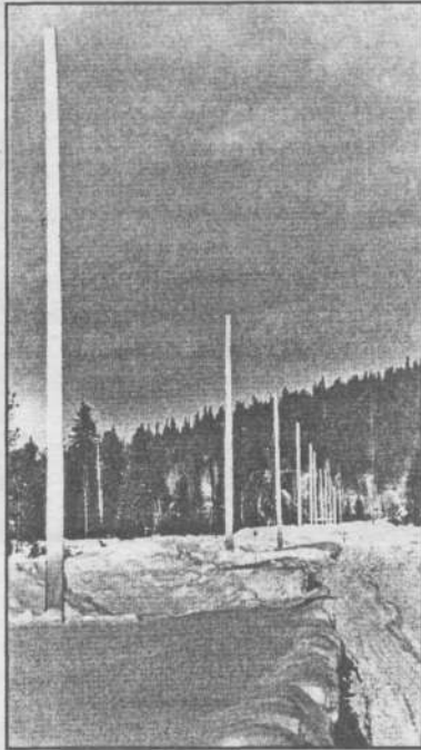
«Шагнула» ЛЭП в поселок Тутуяс.
