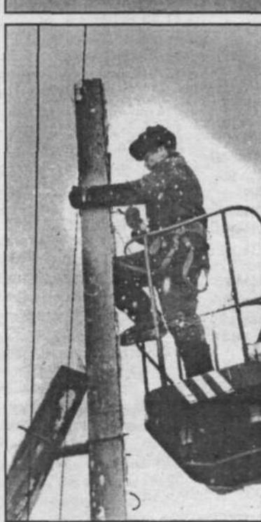
В эти предновогодние дни коллектив участка № 1 ведет капитальный ремонт воздушных линий на улице Таежной. Предстоит заменить 138 деревянных опор на железобетонные, провода и вводы. А до этого ремонтники участка заменили 78 опор на улице Сенной.
