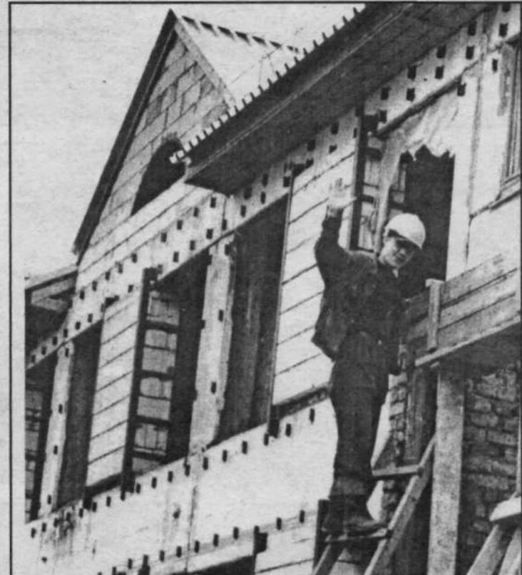
Еще осенью прошлого года ООО "Ремир" начало реконструкцию здания бывшего детского сада под роддом. За это время строители сделали новую крышу, простенки, перегородки, крылечки, вентиляционные камеры и многое другое. Впереди отделочные работы. В соответствии с новыми строительными требованиями здание роддома будет сейсмоустойчивым.
