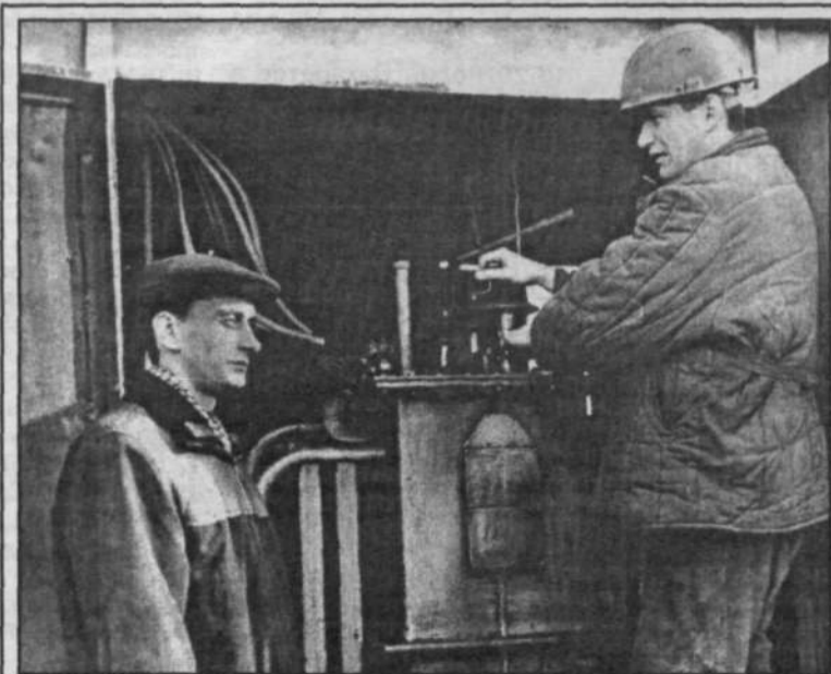
Старший мастер Владимир Анатольевич Бородин и электромонтер Тимофей Евгеньевич Олейник проводят текущий ремонт трансформаторной подстанции в микрорайоне ГРЭС.
