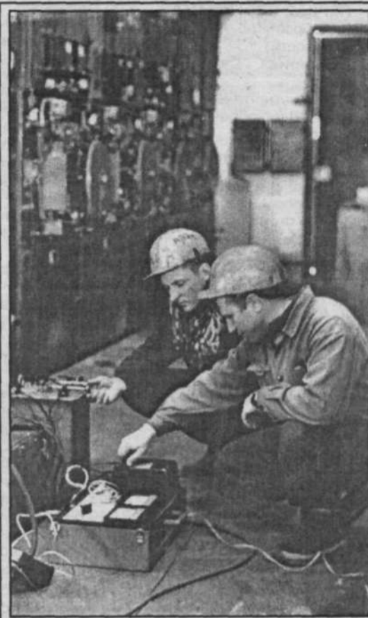
Электромонтеры Юрий Алексеевич Егзов и Максим Евгеньевич Краснов занимаются ревизией масляного выключателя и отстройкой защиты на РП № 6.
