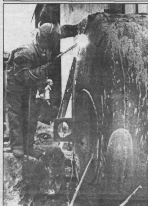
Сейчас в "Тепловике" активно готовятся к отопительному сезону. Идет капитальный ремонт пятого котла. Необходимо заменить пневмомеханический забрасыватель, колосниковую решетку, усилить фундамент под котлом. А в бойлерной усовершенствуется технологическая схема сбора конденсата. В эти работы входит установка конденсатных насосов, прокладка новых труб для сбора конденсата, установка конден-
