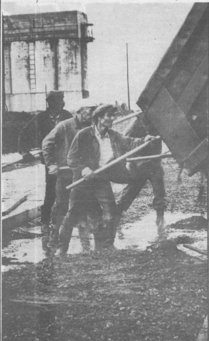
Недалеко от автомобильной трассы на территории АП "Сибкон" развернулась строительная площадка. Здесь со временем будет кирпичный завод
