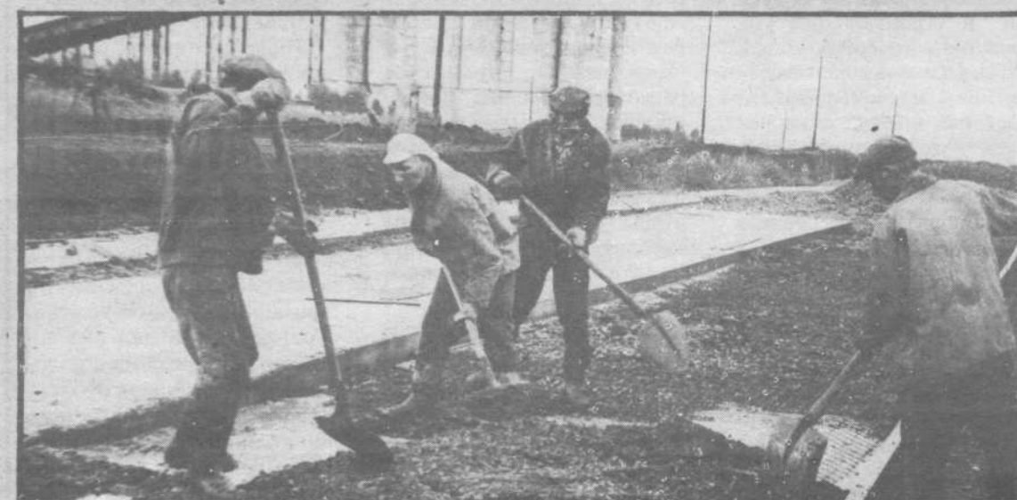
рова дел, как говорится, непростой. На этом объекте она работает более недели. Уложено уже много десятков кубических метров бетона.
