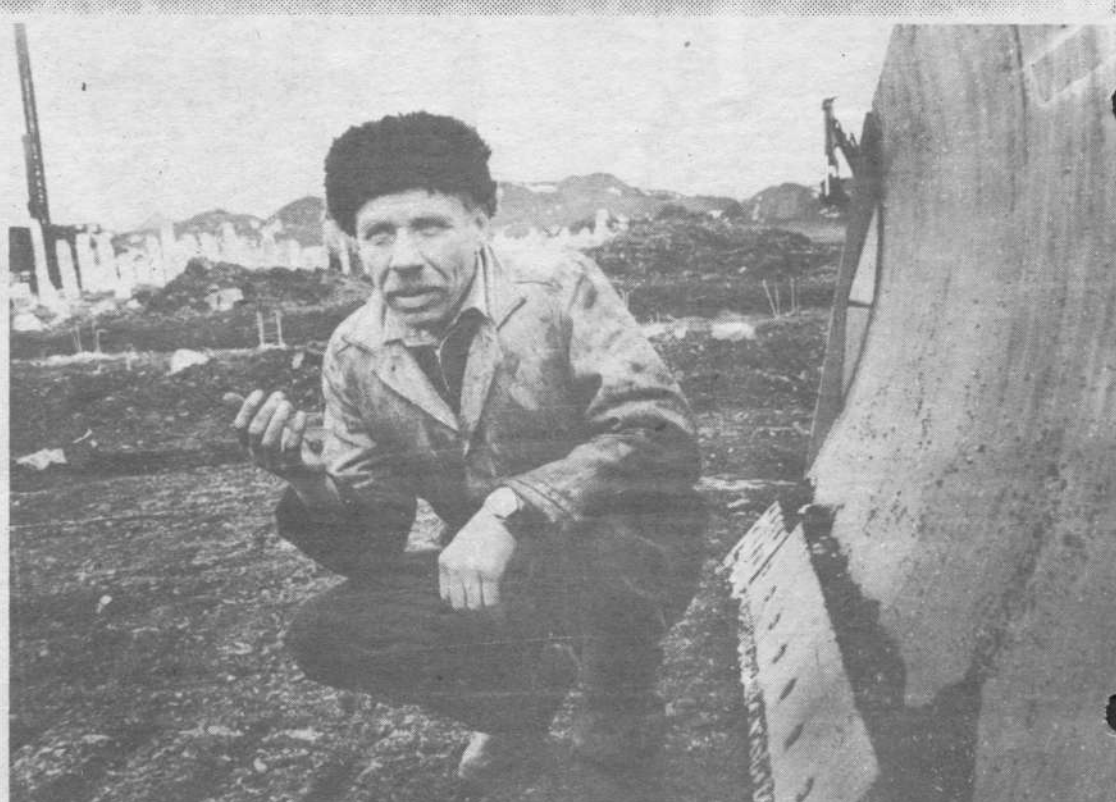
На строительстве городского хладокомбината машинист бульдозера Т-130 М. А. Ушаков из акционерного общества "Шахтостроймеханизация" работает с октября. Можно сказать, с первого колесика. На своей технике Михаил Алексеевич подготавливает площадку для строительства, делает подъездные
