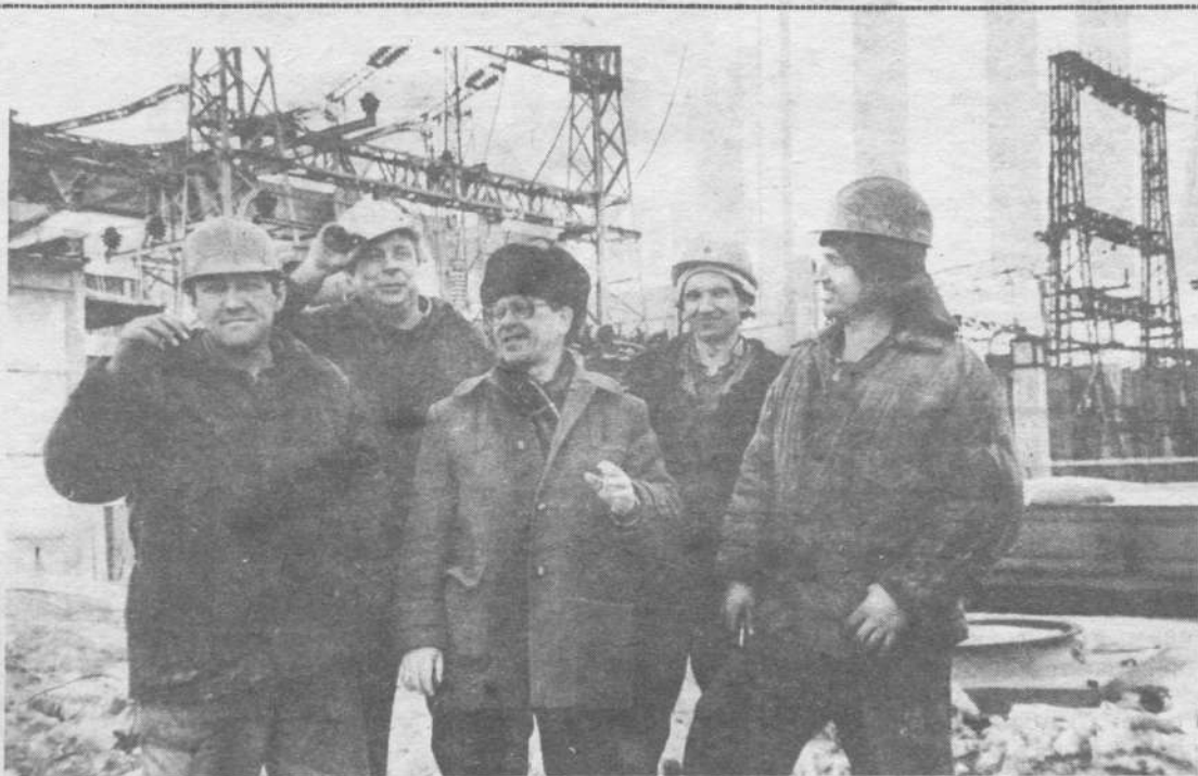
Бригада электромонтажников И. П. Тимошенко с Новокузнецкого прорабского участка известна в монтажном управлении № 1 треста «Электросибмонтаж» как передовой коллектив. Уверенно и слаженно производят работы члены бригады на объектах ТЭЦ Западно-Сибирского ме-
