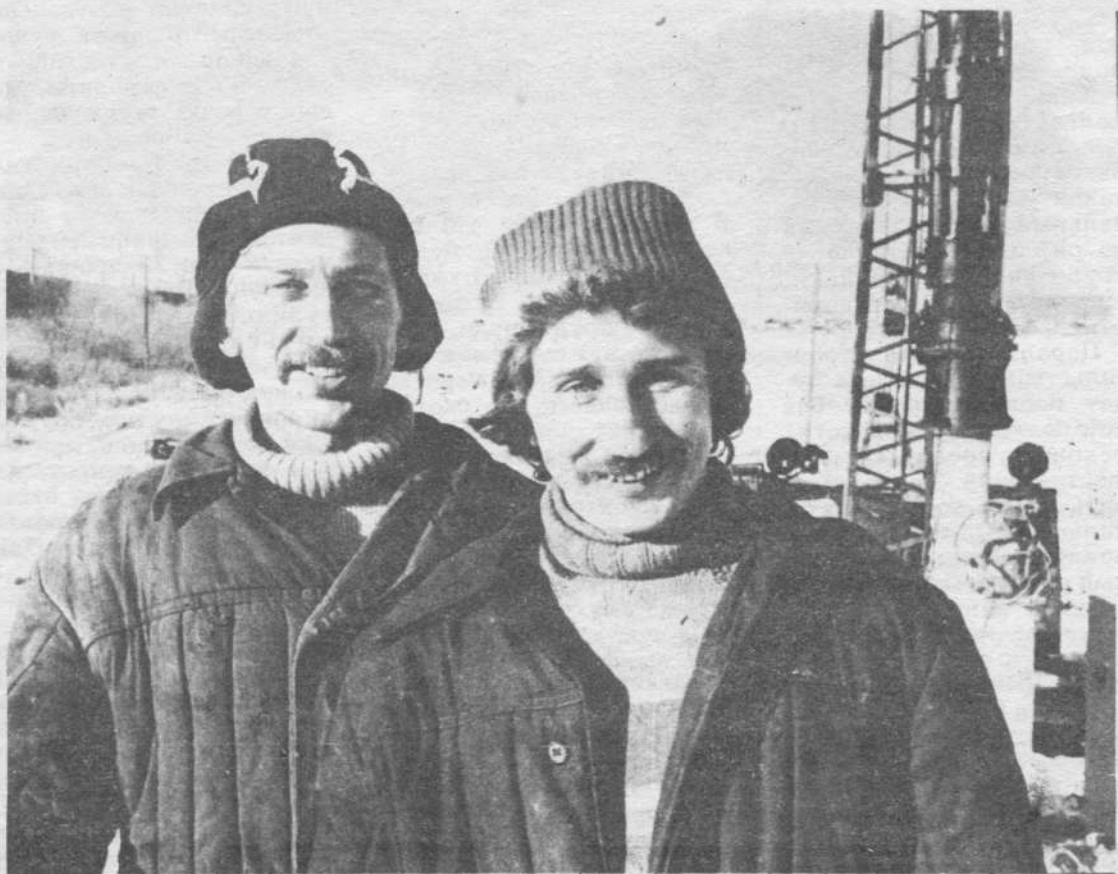
Игорь Алексеевич Филатов, — машинист копровой установки, а Владимир Васильевич Галкин — его помощник. Оба трудятся в строительном управлении Томусинской
