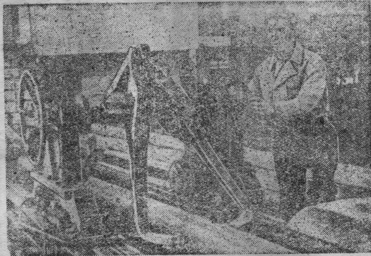
Техник-рационализатор лесопильного завода имени Куйбышева (Сталинград) тов. А. М. Егоров, сконструировавший портативную комлевую тележку для подачи бревен к лесопильной раме. Годовая экономия от одной тележки составляет 26 тысяч рублей.
