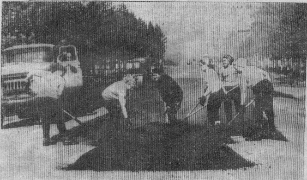
На снимке: бригада Р. К. Березиковой во время укладки асфальта.
