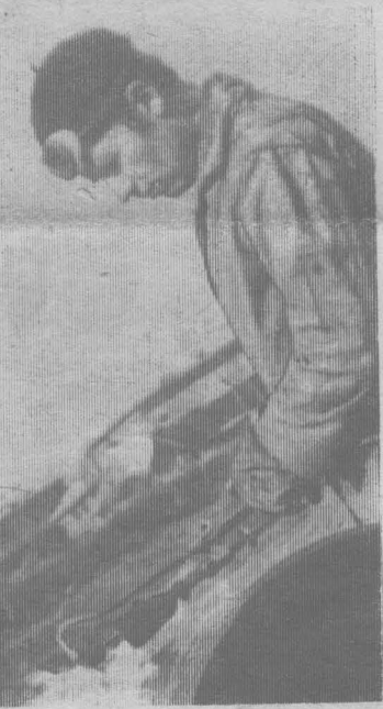
На снимке: газосварщик Б. М. Масленников; машинист экскаватора Г. Антонкин (вверху) со своим помощником А. Ф. Спирковым; нитка трубопровода.
