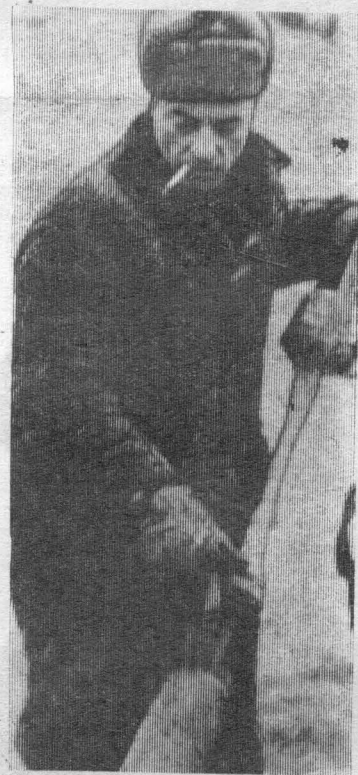
На этом снимке звеньевой бетонщиков Томусинского песчаногравийного карьера Иосиф Михайлович Шишак производит заливку железобетонных свай. Ежедневно вместе со своими рабочими он перевыполняет сменные задания. На производстве его знают как опытного звеньевого.
