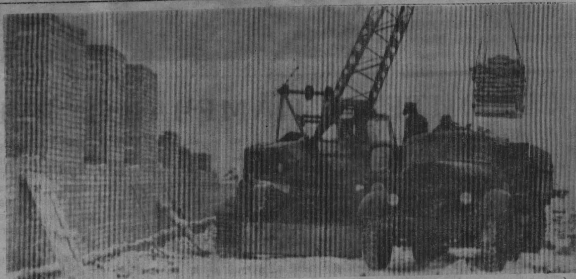
Указом Президиума Верховного Совета РСФСР бригадирю каменщиков строительного управления Томусинского ГРЭС Николаю Федоровичу Шахову присвоено почетное звание «Заслуженный строитель РСФСР». В настоящее время рабочие из его бригады ведут кладку служебного помещения Томусинского теплосетевого района.
