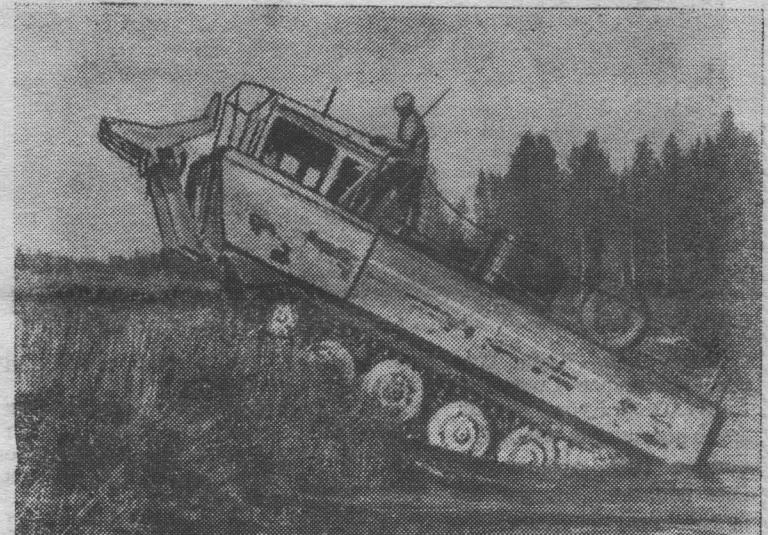
**ПЕТРОЗАВОДСК.** Государственной комиссией закончены испытания плавающего тракторного агрегата «ТП-90» (на снимке), созданного конструкторами Онежского тракторного завода. Основное назначение машины — скатка древесины в воду и на лед, установка редийных сооружений, разборка заломов и т. п. «Онежец» с успехом заменяет лебедки и водо-
