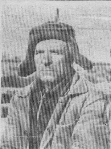
Бригада Гавриила Николаевича Чульжанова работает на строительстве клуба в поселке Ключевом.
