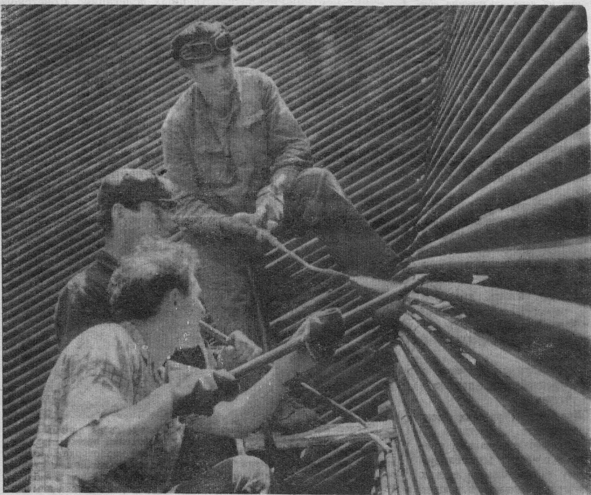
Каждый день с Северной сборочной площадки идет отгрузка укрупненных блоков котла на главный корпус.
