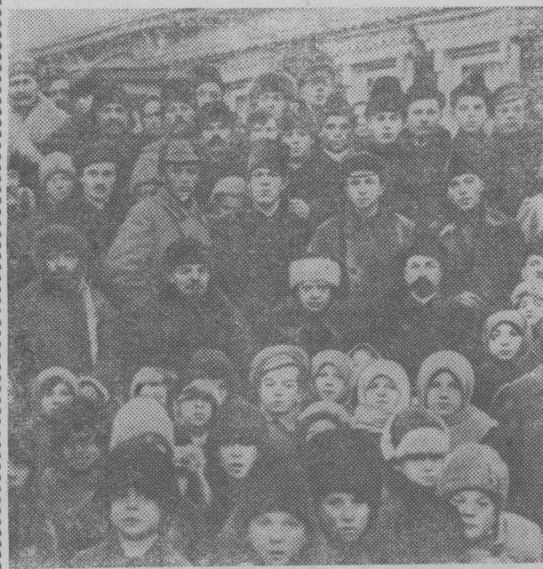
В. И. Ленин и Н. К. Крупская в группе крестьян села Кашино Волоколамского уезда Московской губернии на празднике, посвященном открытию Кашинской электростанции 14 ноября 1920 года. Фото Ф. Феофанова.
