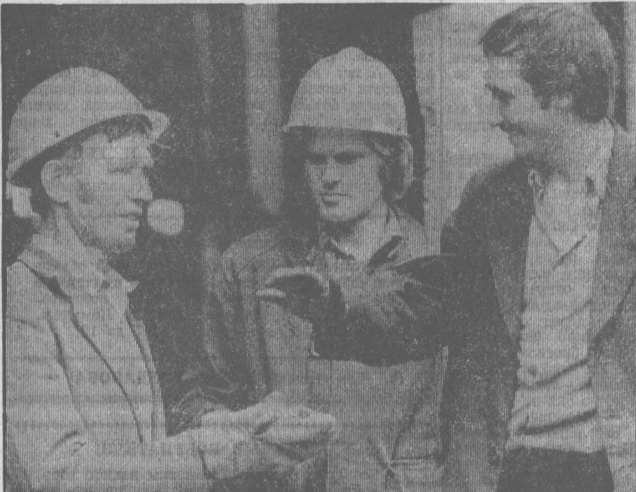
На снимках нашего корреспондента Ю. Мальцева запечатлен момент монтажа технологических площадок в цехе. Ведут его монтажники А. В. Балагин, сварщик М. В. Лабонин, машинист автокрана В. Н. Прудников из Томусинского ПСМУ № 4.
