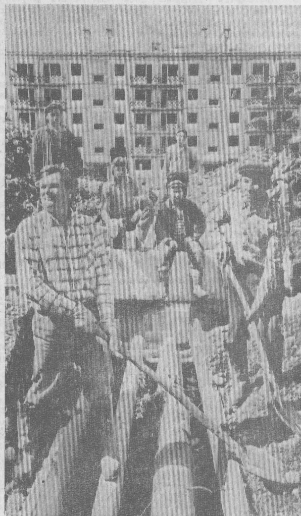
На снимке: бригада трубоукладчиков В. Анашкина на объекте. Фото Ю. МАЛЬЦЕВА.
