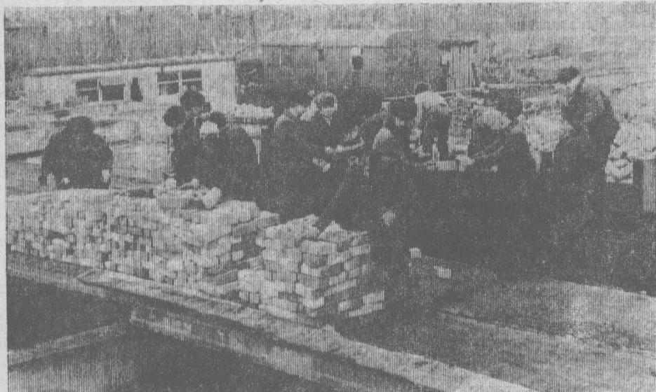
Всем миром вышли в день субботника на возведение корпуса будущей столовой локомотивного подменного пункта депо станции Междуреченск. Они занимались подвозкой кирпича и объекту, его складированием и кладкой стен.
