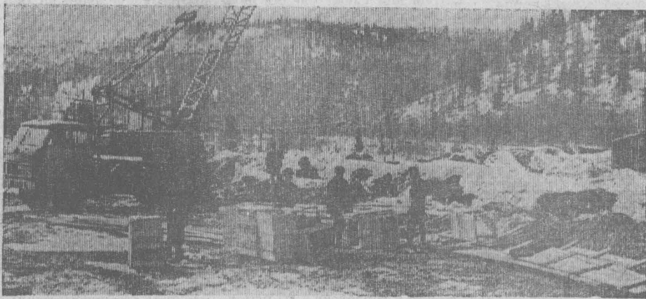
Общий вид строящегося свиноплекса. Фото Ю. МАЛЬЦЕВА.
