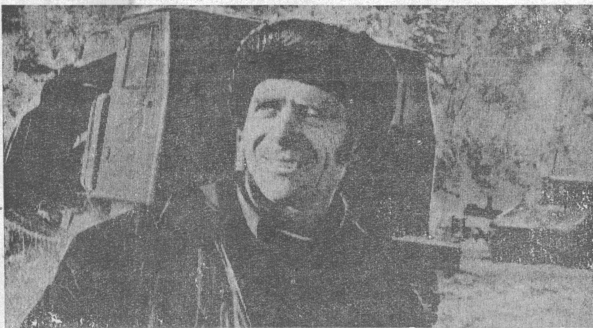
Строительство: на контроле — пусковой объект
