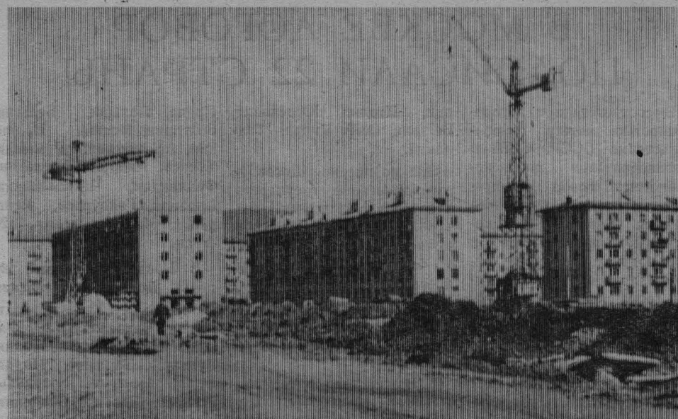
Идет строительство 13 квартала.
