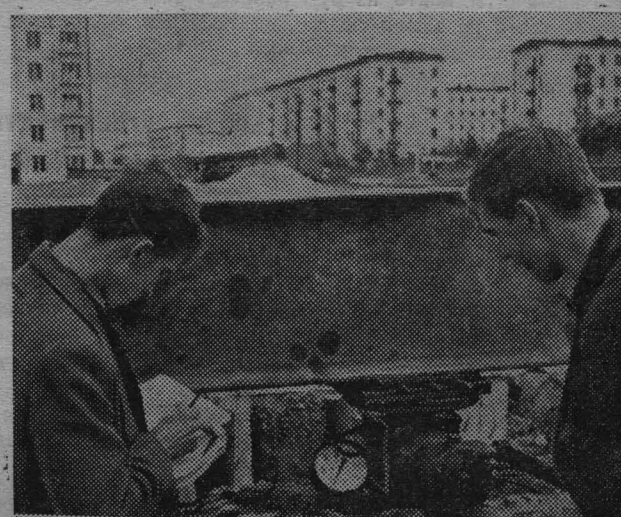
В СССР создана опытная стройплощадка. Ее польза огромна. На снимке: мастер Ю. И. Иванов (слева)
