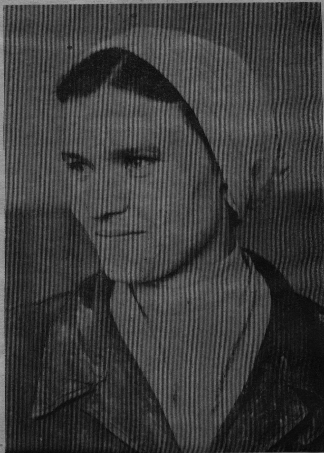
В здании хлебозавода полным ходом идут отделочные работы. Постоянно перевыполняет сменное задание в полтора раза штукатур Зоя Лебедева. В работе ей помогают знания, получаемые в вечернем горностроительном техникуме. Зоя студентка четвертого курса. На снимке: штукатур Зоя Лебедева.
