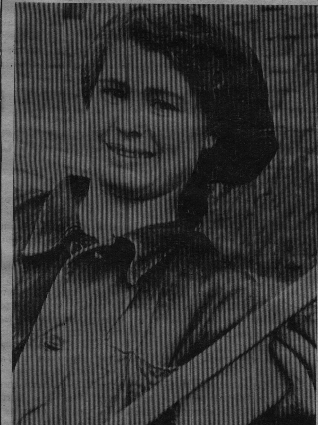
Бригада штукатуров, руководимая Степаном Сидоренко, задает тон соревнованию среди строителей за досрочное выполнение семилетки. Отлично работает в этой бригаде штукатур Нина Винокурова, которую вы видите на снимке.
