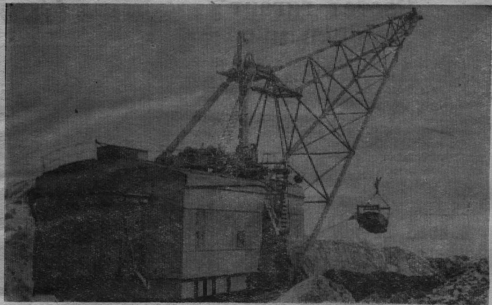
Экскаватор ЗШ-10-60. На этом гиганте работает бригада Александра Выродова.
