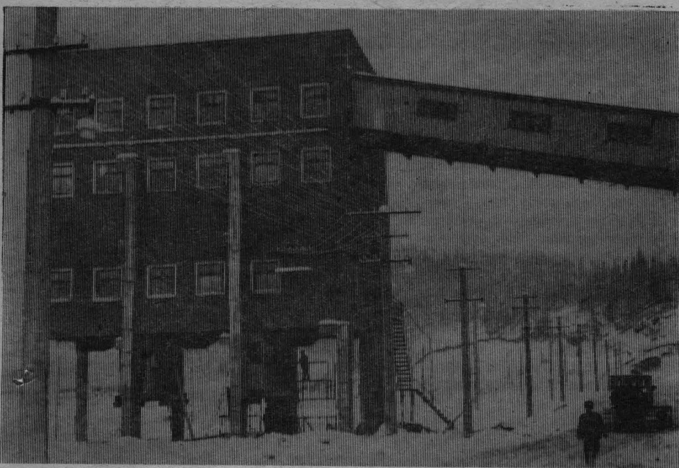
Это погрузочные воронки новой шахты. Скоро отсюда в железнодорожные вагоны будет подан первый уголь.
