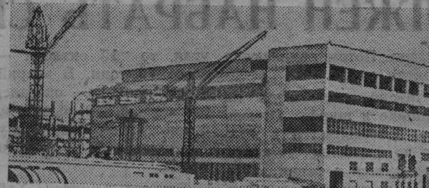
**ЛИПЕЦК.** Строительство агломерационной фабрики Липецкой Магнитки вступило в решающую fazу. Завершается сооружение главного корпуса агломерации и других объектов гигантского комплекса. Полным ходом идет монтаж сверхмощной агломерационной машины непрерывного действия площадью спекания 252 квадратных метра. Этот уникальный агрегат будет выдавать несколько миллионов тонн оффлюсованного агломерата в год. По своей производительности и техническому оснащению он не имеет равных в мире.
