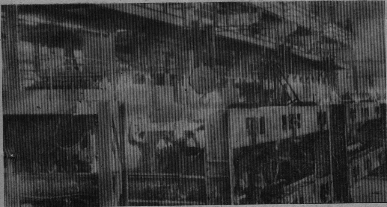
Так выглядит главный корпус нового завода КПДС в нашем городе.
