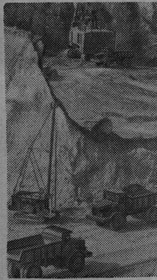
**Житомирская область** (верхний снимок). На Стрыжевском карьере Коростышевского шахтостроительного управления начались производственные испытания транспортно-отвального моста, предназначенного для вскрытия угольных месторождений. Эта машина создана группой украинских специалистов.
