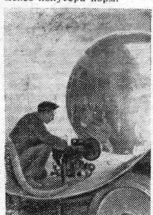
На снимке: электросварщик А. Г. Шишинин готовит автомат для сварки корпуса котла.
