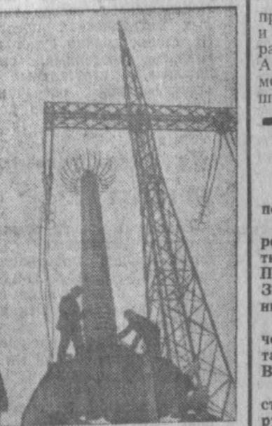
**Строящаяся линия электропередачи Донбасс — Западная Украина** направлением 750 киловатт и протяженностью 1117 километров объединит четыре энергосистемы Украины: «Донбассэнерго», «Днепроэнерго», «Винницагазерго» и «Львовэнерго». На снимке: монтаж реактора ЛЭП-750.
