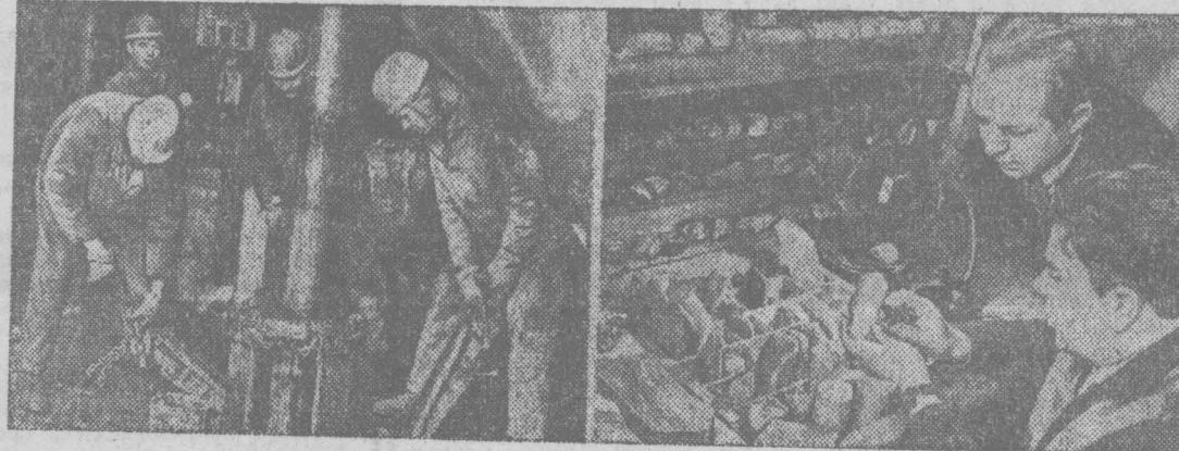
Реализация глобальной программы изучения недр Земли в СССР начата бурением Кольской сверхглубокой скважины. Первый этап его закончен на отметке 7263 метра. Сейчас ведутся подготовительные работы к углублению. Скважина стала своего рода техническим, геофизическим и геологическим полигоном, где ведут исследования около 20 геологических институтов.
