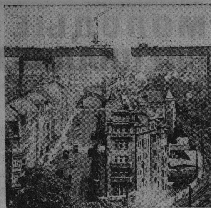
В Праге строится самый большой в республике мост. Основой его служит 40-метровая железобетонная опора. Протяженность самого моста — 485 метров. Он будет переброшен через долину Нусле и соединит город со строящейся автострадой. И, таким образом, явится частью магистрали, пересекающей Прагу с севера на юг. Нусельский мост вступит в эксплуатацию в 1970 году. Он рассчитан не только на автотранспорт и пешеходов. В первом ярусе этого моста протянется линия будущего Пражского метро.
