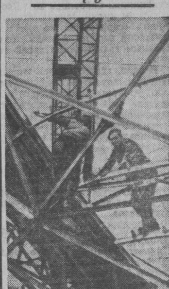
Монтаж мощного радиотелескопа на территории астрономической обсерватории Краковского университета (Польша). Диаметр антенны радиотелескопа — 12 метров. Фото ЦАФ—ТАСС
