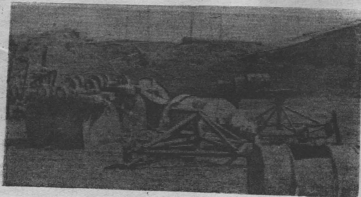
Свалка оборудования у здания стройгруппы.
