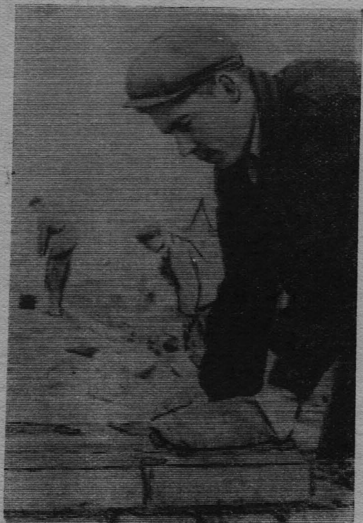
Товарищи по работе уважают Сафрона Ивановича Быкова за горячую хватку в труде. Он быстро наносит раствор и укладывает кирпичи в стены нового жилого дома. С. И. Быков — один из лучших каменщиков БШСУ, всегда перевыполняет норму, идет в рядах передовиков семилетки.
