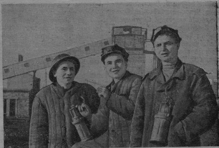
В Донецкой степи, рядом со станцией Фашевка, построена шахта «Сумская-комсомольская». Она построена руками комсомольцев досрочно — к 40-й годовщине Советской Украины.
