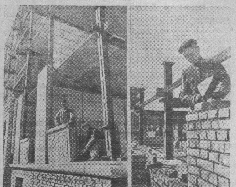
Москва. На Хорошевском шоссе развернулось скоростное строительство крупнопанельных жилых домов. Строительство ведется индустриальными методами — все детали изготавливаются на заводе, а на строительной площадке ведется только монтаж. На снимке: слева — установка облицовочных блоков. Справа — камешник-стахановец Л. С. Кашашиков за кладкой цокольного этажа. Фото Н. Кирева. Пресскляше ТАСС
