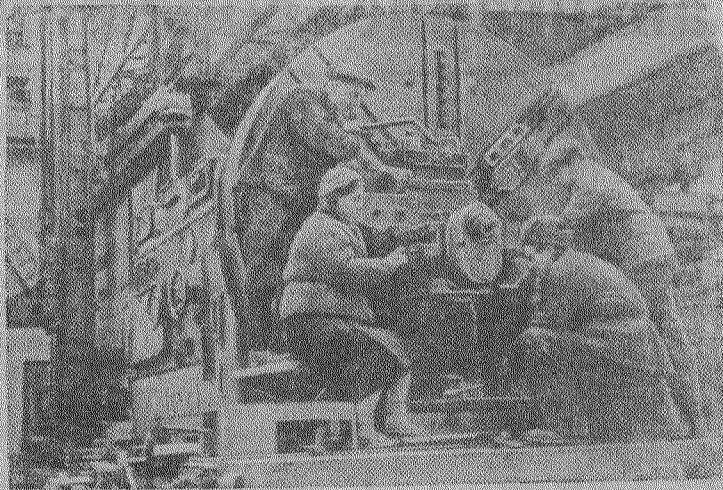
На Ленинградском судостроительном заводе имени А. А. Жданова. Стахановская бригада слесарей А. В. Давыдова монтирует уникальный токарный станок. Фото Н. Каранова.
