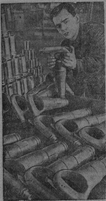
Облегченный отбойный молоток. Ленинградский завод пневматических машин «Инсма» выпускает новый пневматический отбойный молоток ИОМ-7, предназначенный для верхних работ в шахтах.
