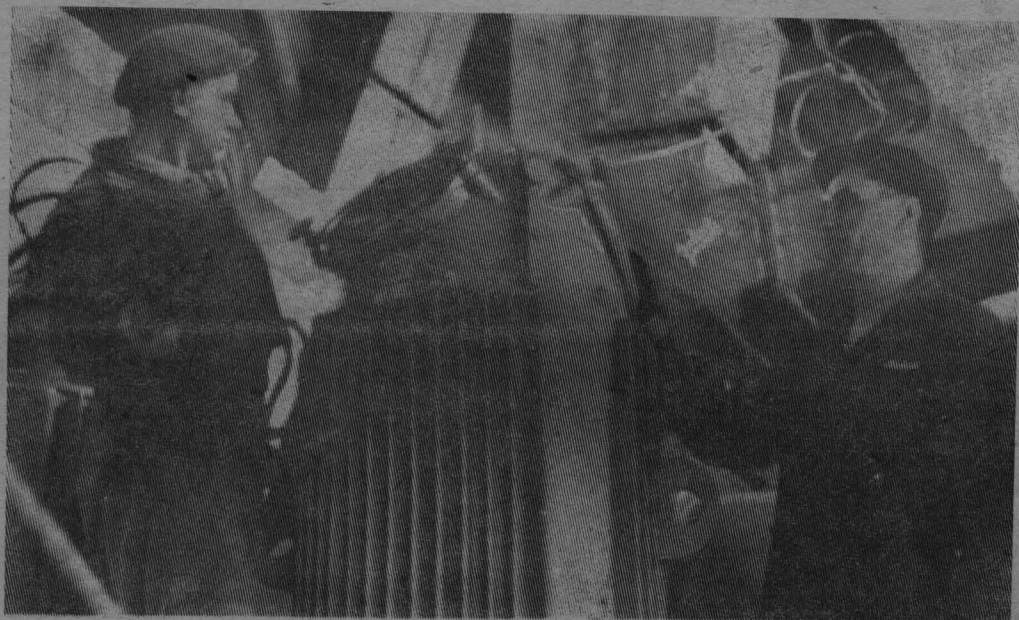
Высокой производительностью труда отличается бригада слесарей-монтажников Проконьевского шахто-монтажного управления № 2, возглавляемая т. Римским. Работая на строительстве ЦОФ, этот коллектив выполняет нормы выработки на 150 процентов и более. На снимке: бригадир Н. П. Римский и монтажник А. И. Сергеев ставят центрифугу в главном корпусе. Фото А. УСКОВА.
