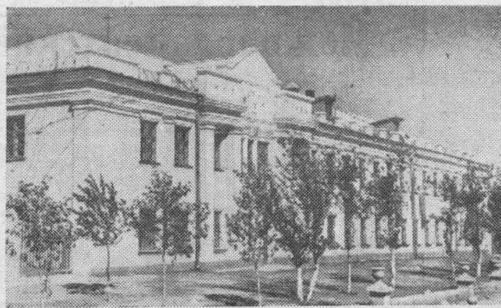
На снимке: здание административно-бытового комбината шахты № 12.
