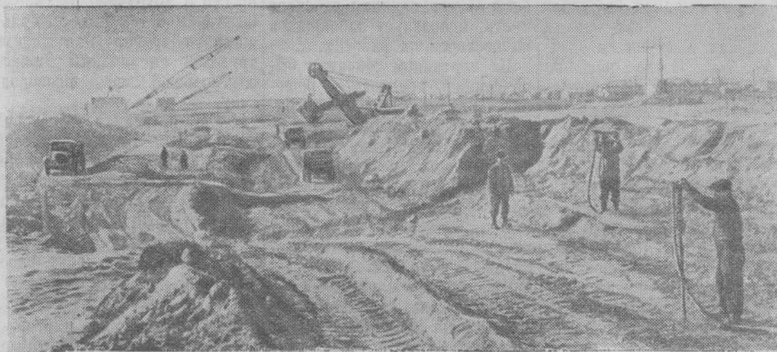
Тахиа-Таш. Строительство обводного канала.
