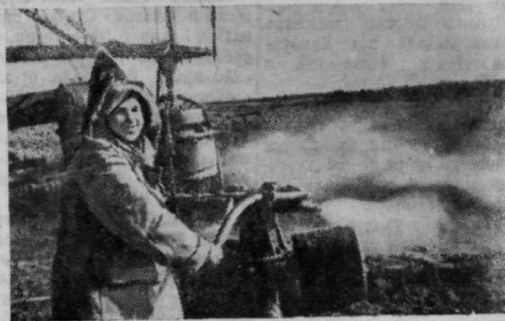
Ленинградская область. Механизированная добыча торфа. На торфопредприятии «Назия». Гидромониторщик С. И. Денисенко за размывом торфа.
