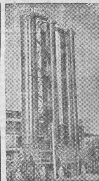
**Мариуполь.** Недавно вступившая в эксплуатацию газоповышительная станция. Она транспортирует газ из коксохимического завода на завод имени Ильича и в город. С пуском этой станции завод имени Ильича ежемесячно экономит до 2000 тонн жидкого топлива, а город — сотни тонн угля.
