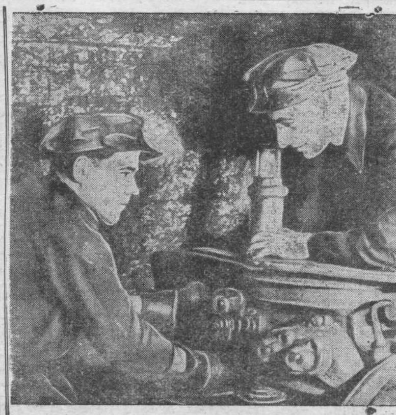
Ростовская область. На шахте имени ОГДУ треста «Несветайантрацит» успешно идут испытания мощной врубовой машины «МБ-60», сконструированной московским инженером Н. А. Шуриным. Новая машина прошла более 2,5 тысячи погонных метров пластига при баре в 2,1 метра и нарубила около 13 тысяч тонн угля. Ее производительность втрое превышает врубовку «ГТК-3». Сейчас Горловский машиностроительный завод имени Кирова приступает к серийному производству этих машин.
