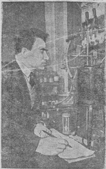
Научный сотрудник института горючих ископаемых Академии наук СССР комсомолец Е. М. Тайц разработал прибор для быстрого определения качества коксующихся углей. На снимке: Е. М. Тайц определяет коксующесть углей при помощи прибора. Фото В. Шаровского. Фото ТАСС
